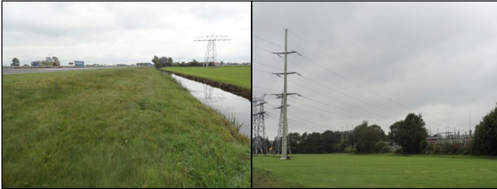
Figuur 3 Zuidberm A7 tussen knooppunt Joure en Oudehaske, met veel Pitrus (foto links); Trafostation bij Oudehaske, eindpunt van het kabeltracé (foto rechts)
