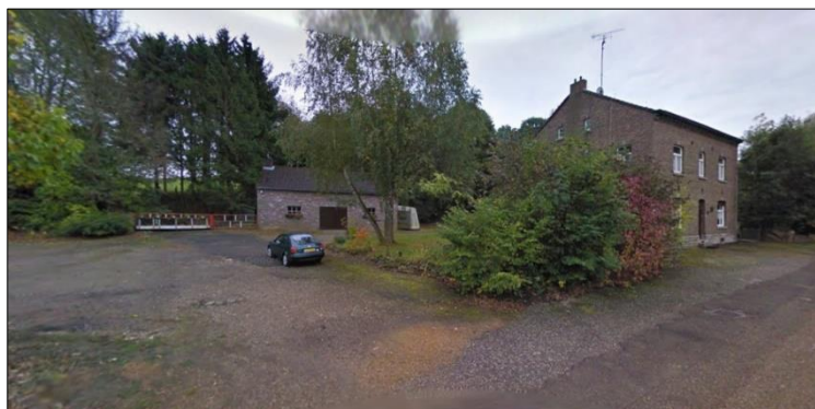
Foto bestaande situatie (bijgebouw en woning)
