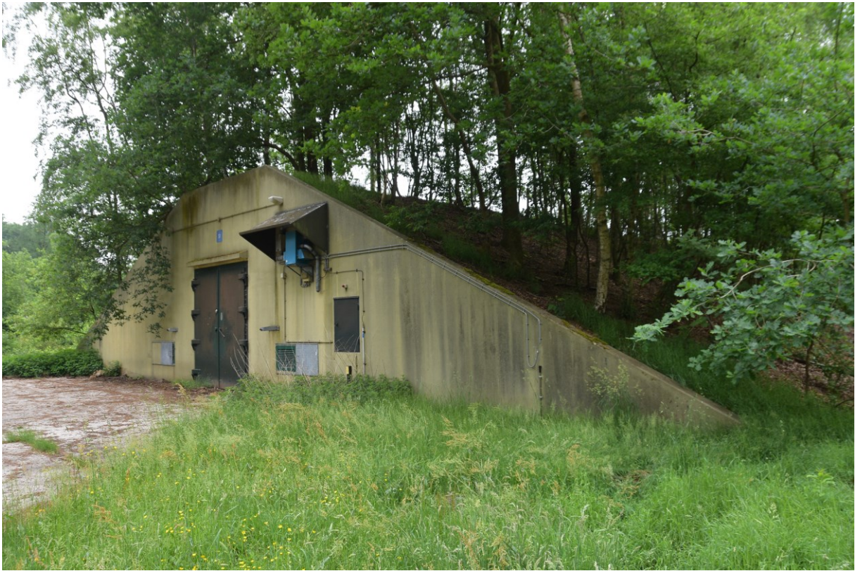
Figuur 3.4. Impressie buitenzijde grond bedekte bunker.
