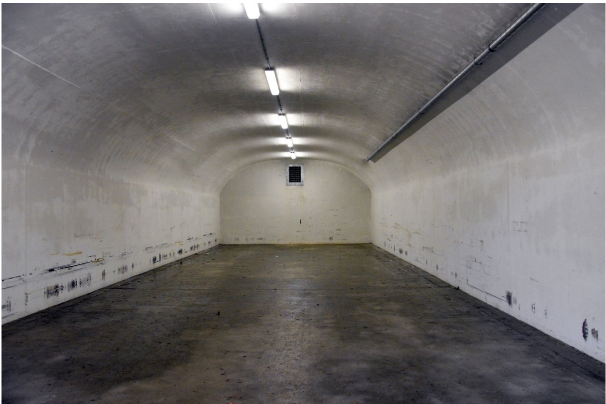
Figuur 3.5. Impressie binnenzijde grond bedekte bunker.
